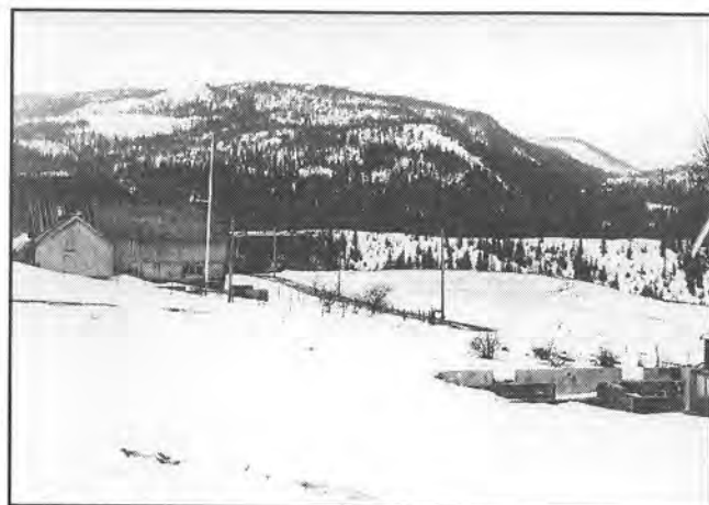
Utflyttingsbidraget som vart gitt førte til at mange hus vart revet og fraflyttingsspøkelset hang over hele bygda. Bildet viser Prestberg (Kulslia mellom)
