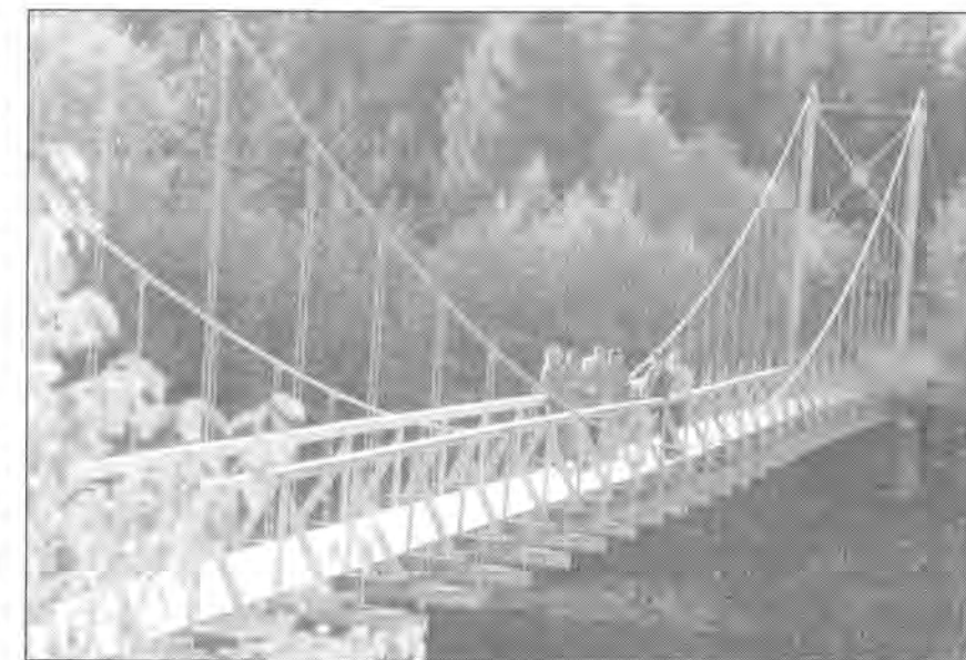
Et av dugnadslaga på den nyrestaurerte Røsbua. I skogen bak brua ligger ett av de oppsatte toalettbygningene.
