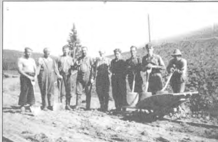
Vegarbeid i Nordkleiva. Fra venstre: Jon J. Haugan, Håkon Trøbak, Oskar Berg, Trygve Holmli, Olaf Haugseth, Jon Bjørkhaug, Lorenz Rotmo, Sverre P. Sellæg, Ingemar Kolstad.
