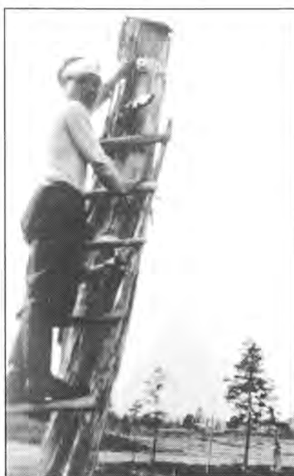
Reparasjon av linja til Skjækerdammen i 1948. Linja deler seg her, den ene går til Skjækerdammen og den andre til Kulstaddalen. I stolpen: Magne Kjesbu.
