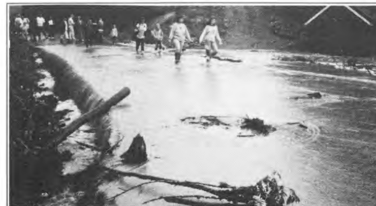
Den 3/8 kom et voldsomt tordenvær over Skjækerfossområdet og både Åkernebbekken, Åkervoldbekken og bekken ved Vestly gikk over sine bredder og flommet over vegen. Ved Vestly gikk røra gjennom vegen tett og det var en stund fare for at vegen skulle graves ut. Som vi ser av bildet var det rene Niagarafossen på nersida av vegen.
