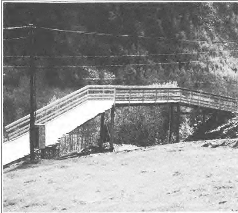
I lysløypa ved Bjartan ble det i løpet av sommeren bygget bro over vegen opp til parkeringsplassen. Dermed er en farlig felle fjernet og løypa er enda mer attraktiv enn før.
