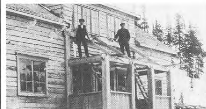
Oppsetting av verandaen på Villaen.
