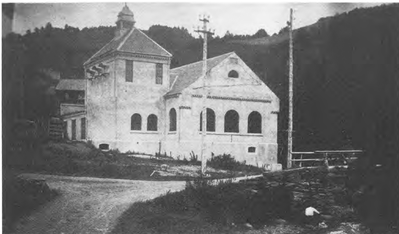
Kraftstasjonen, Ulvillen, Værdalen. Foto: Hj. R. Johansen.
