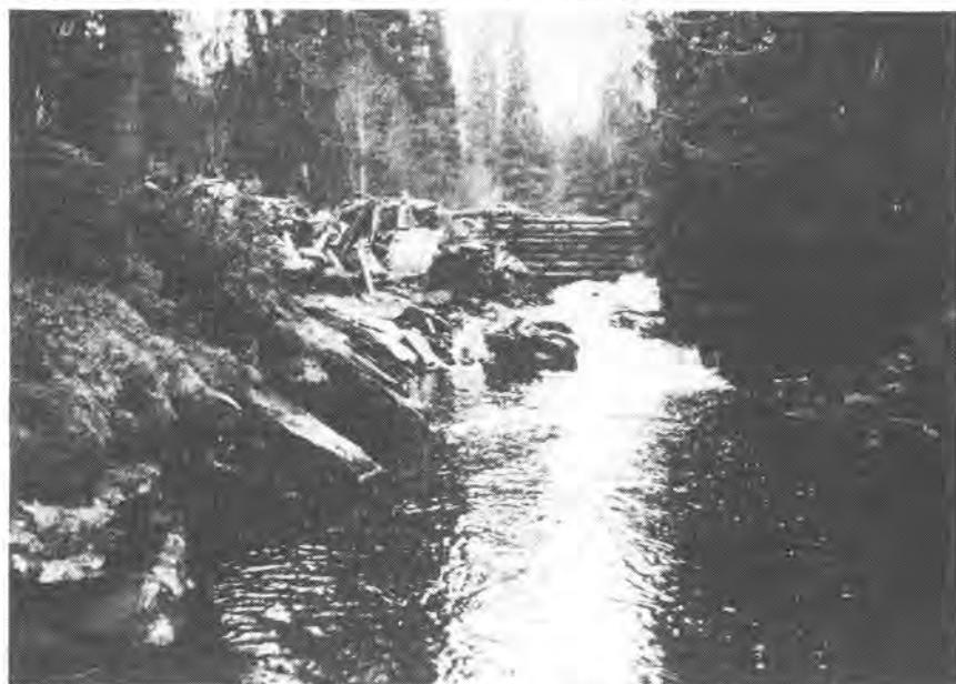
Restene av dammen i Seterbekken.
