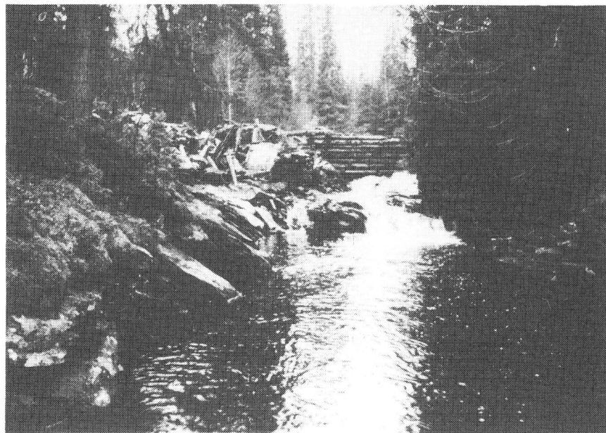
Restene av dammen i Seterbekken.
