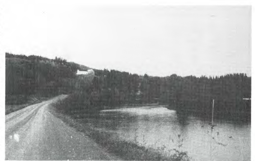
Hengbrua ved Vestly. Åkervolden i bakgrunnen.
