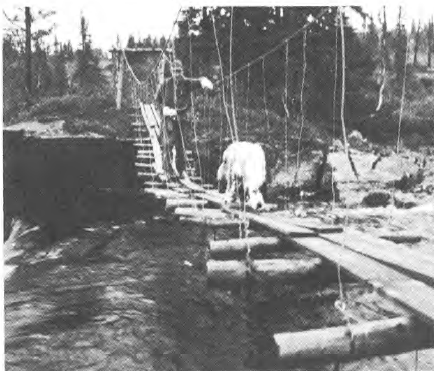
Gangbrua over Tverråa ved Kroken.
