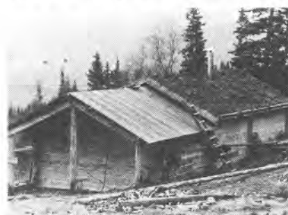
Tin'n under oppbygging.
