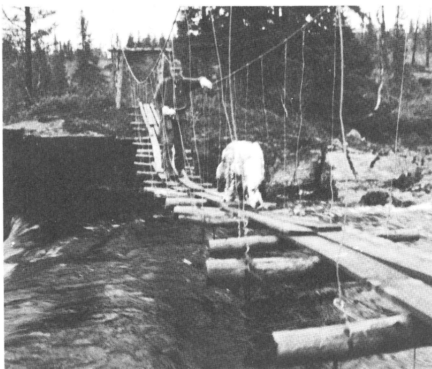
Gangbrua over Tverråa ved Kroken.
