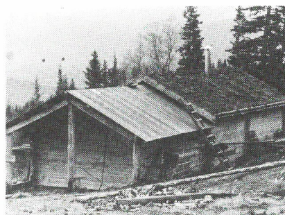
Tin'n under oppbygging.
