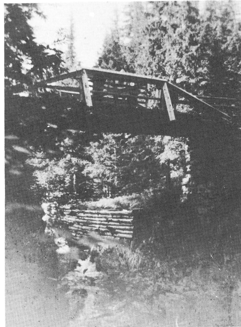
Sætersbrua. Teke etter ho vart lyfta ca. 1. meter opp.
