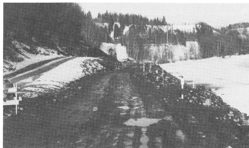
Veien under utbedring.
