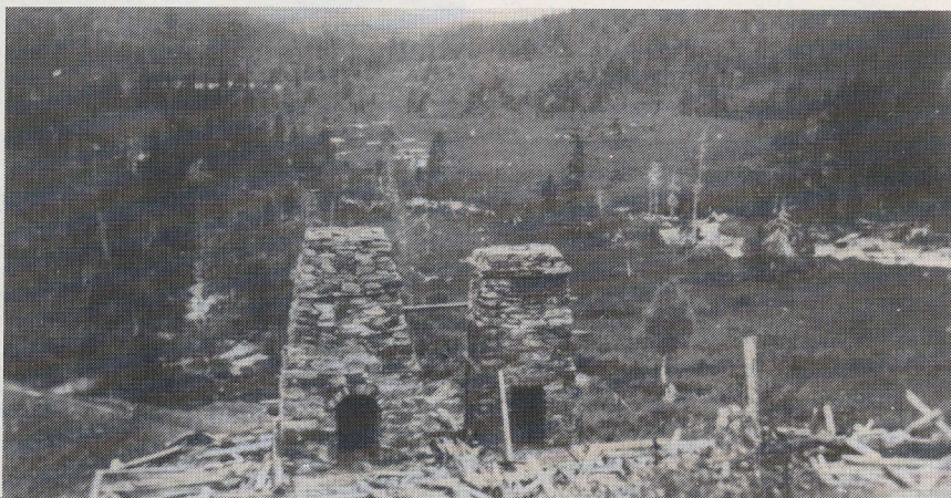
Gammelt bilde fra Malså Kopperverk. Her framgår det at det var to smelteovner. I dag finnes restene etter den til venstre.
