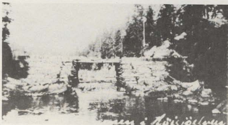
Langtjønndammen i Høysjøelva.
