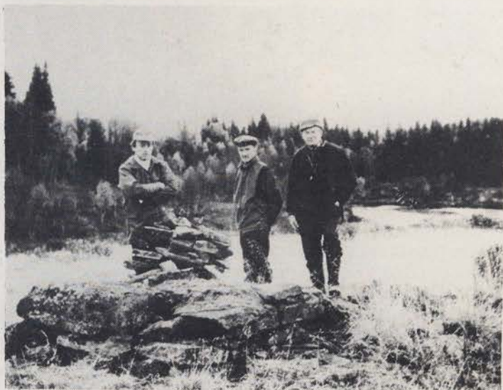
Østpåmoen, med rester av gruva. Husene blev etter krav fra svenske myndigheter brent ned rundt 1931, ifølge Per Ward.
