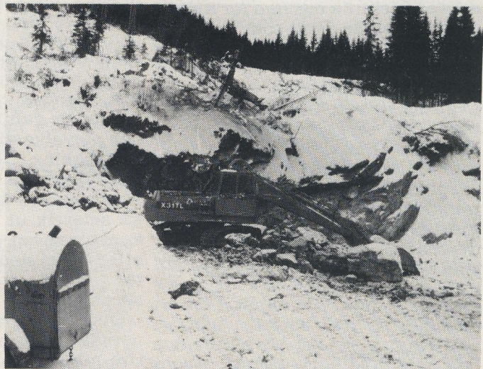
Frå vassdragsvesenet tok til med å bygga veg til steinbruddet ved Haukbekken i fjor vinter og til no, har det endra seg særst mykje ved elva frå Mugda til Kvernhusbekken. Ein molo er bygd på heile denne strekka i løpet av året som snart er gått. At denne forbygginga skulle vori unngått for snart 90 år sidan er ein annan sak. Vi får håpe at elva med dette vert temma for godt og at det som er att av dyrkajord er redda. Bildet viser delar av bruddet ved Haukbekken.
