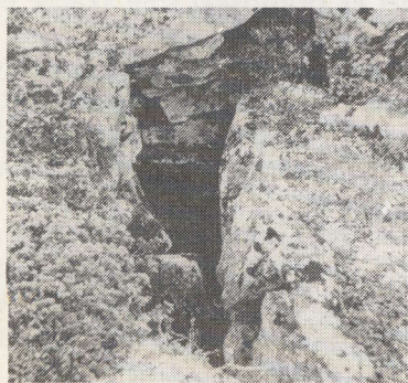
En delvis sammenrast oppmurt dyregrav. De fleste dyregraver mangler steinmur og kan sees som groper i terrenget.
