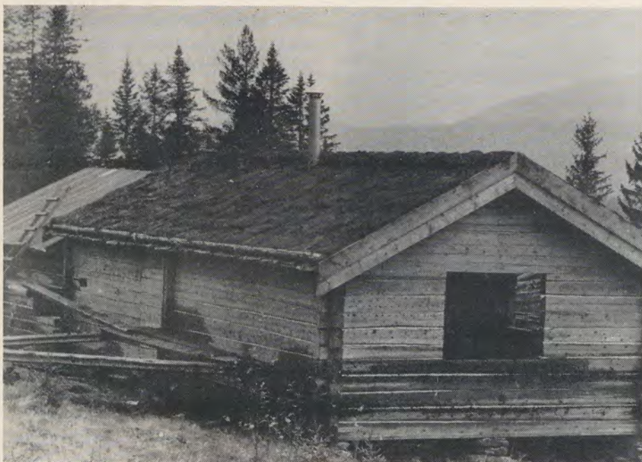
Tinsvoll-prosjektet er kommet godt i gang, det nye huset står nå på plass.
